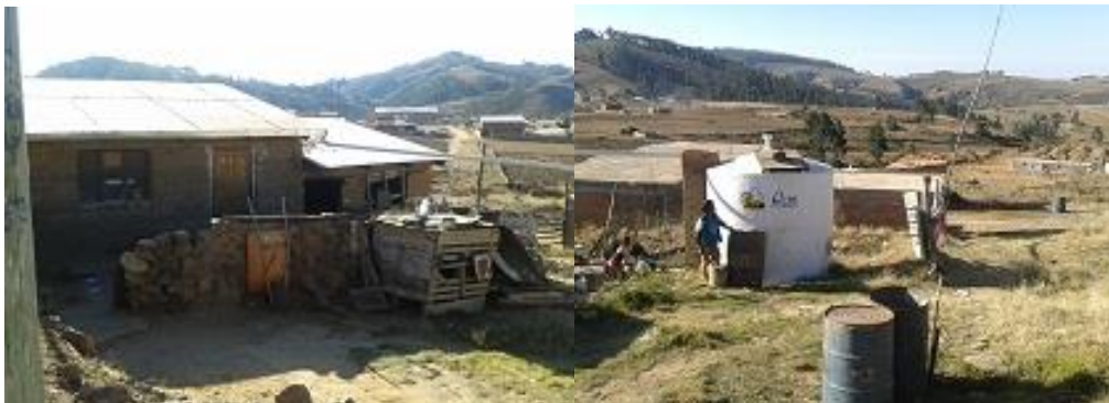
Barrio Alegría, Sistema de captación y almacenamiento de agua de lluvia
